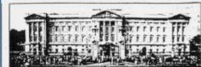
600 Säle, 78 Badezimmer - in den zum Teil maroden Rohren des Buckingham-Palastes nisteten sich gefährliche Legionellen-Bakterien ein.
