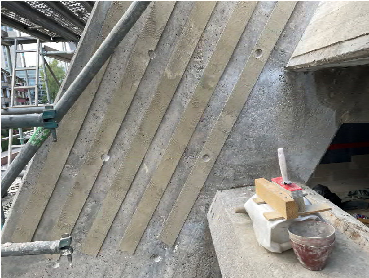
Betonrestauration am Fitnesskubus mit Erhöhung der Betondeckung
