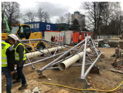
Sanierung - Wiedereinbau der Gitterstützen der Fassade...
