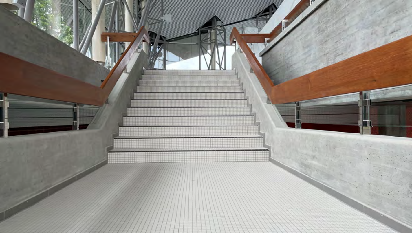
Sanierte Treppe mit Holzhandläufen und Sichtbeton auf die Empore
