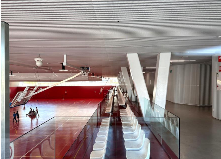
Tribüne Sporthalle, V-Stütze für den Lastabtrag Bad im 2.OG darüber
