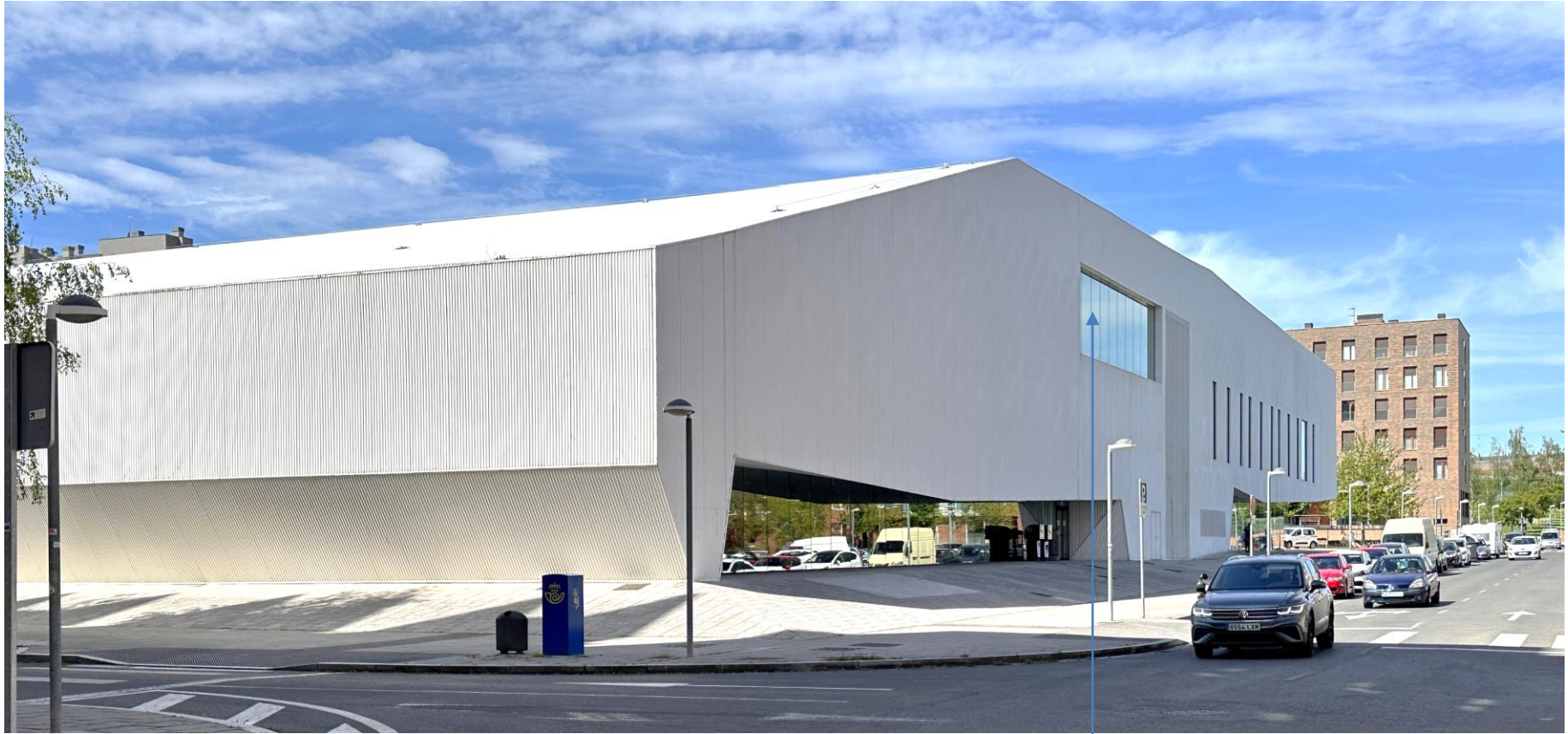
Stadtteilzentrum in Vitoria-Gasteiz, Spanien Arch. ACXT, Spanien
