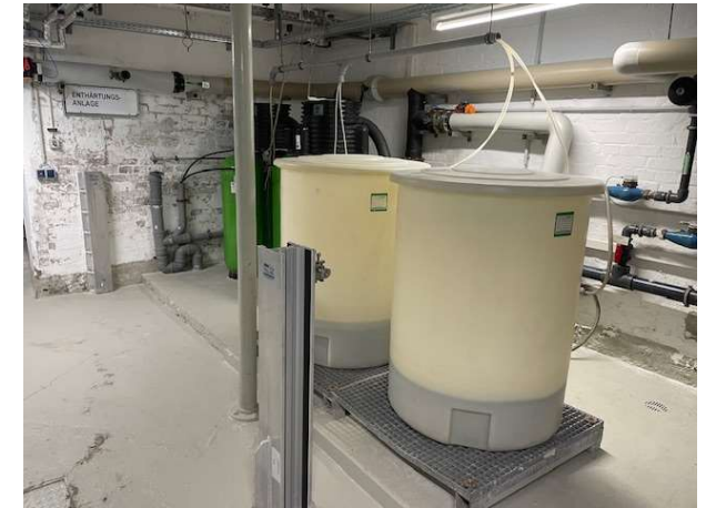
Enthärtungsanlage
