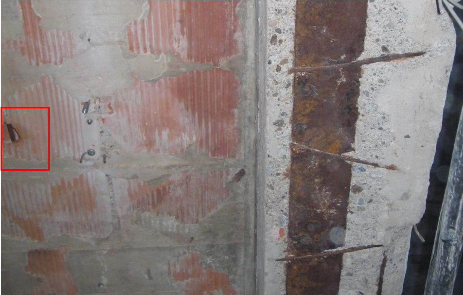
Ziegelhohlkammerdecke im denkmalgeschützten Bestand
