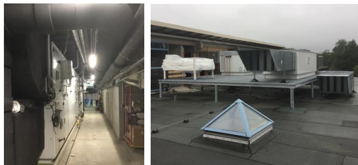
Eingeschränktes Platzangebot bei Baumaßnahmen im Bestand.
